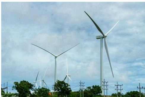
Gambar 2.4 Pembangkit Listrik Tenaga Angin
