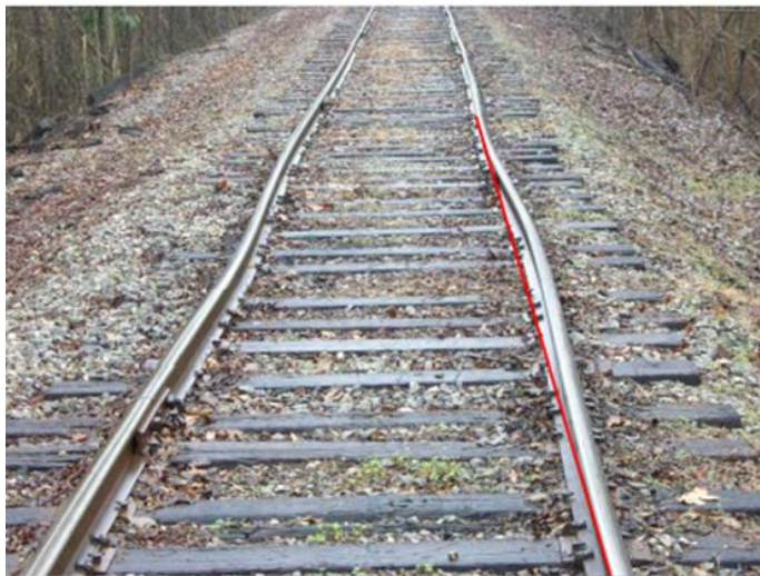
Gambar 2. 3 Parameter Listringan pada lintasan kereta api
