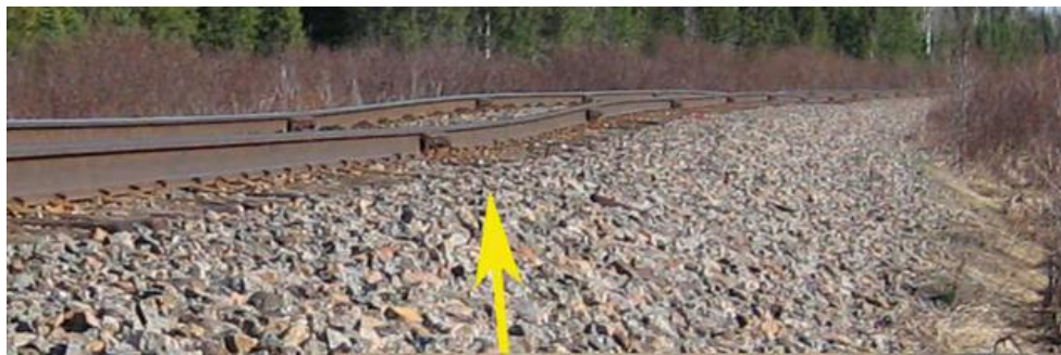
Gambar 2. 5 Ketidakrataan rel pada alinyemen vertical
