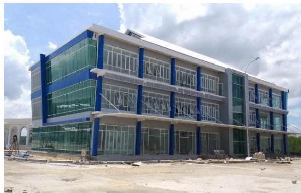
Gambar 4.1 Proyek Pembangunan Fasilitas Gedung dan Utilitas Terminal Petikemas Kendari Newport
