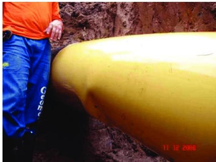
**Gambar 5** Local buckling pada pipa yang mengalami bentangan bebas (Viotti, 2014)
