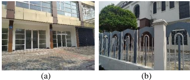
Gambar 4.17 Dokumentasi Klasifikasi Penggunaan Bangunan; (a) Ruko; (b) Masjid
