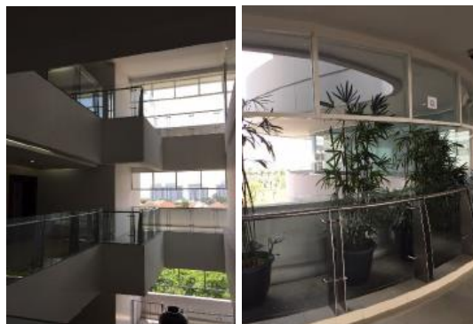
Gambar 28 Void dan Akses Sirkulasi Udara dalam Gedung, (Penulis, 2020)
