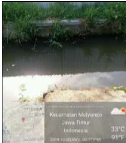
Gambar 1-4 Dokumentasi Saluran Sekunder Bagian Belakang Perumahan Sutorejo
