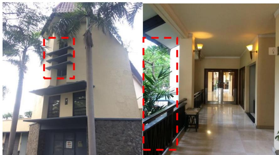
Gambar 4.26. Bukan *Cross Ventilation* pada Facade Bangunan dan Ruang Transisi (Dokumentasi Pribadi, 2020)
