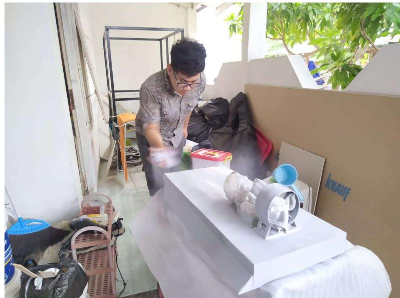
Gambar 4. 70 Pemberian cat primer pada prototype
