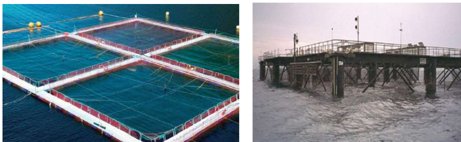
Gambar 2.3 Rigid Cage System paling laris terjual (kiri), memiliki feed storage , electricity generator , dan kabin kecil untuk pekerja (kanan)
