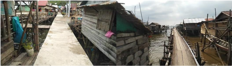
Gambar 4. 44 Jalan Penghubung Tempat Pengolahan
