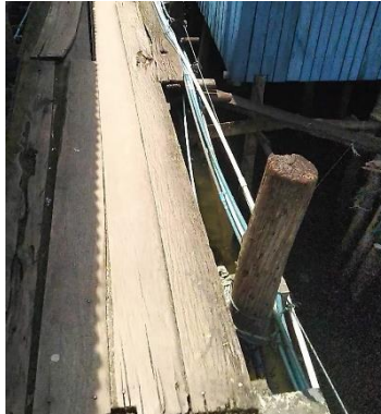
Gambar 4. 46 Selang Air pada Jalan Penghubung
