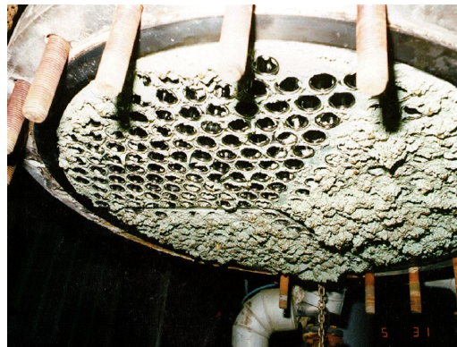
Gambar 2 14 Fouling pada permukaan perpindahan panas shell and tube
