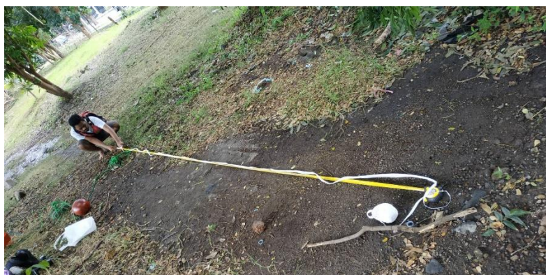
Gambar Pengukuran Panjang Tali Untuk Membantu Pemasangan Bouy
