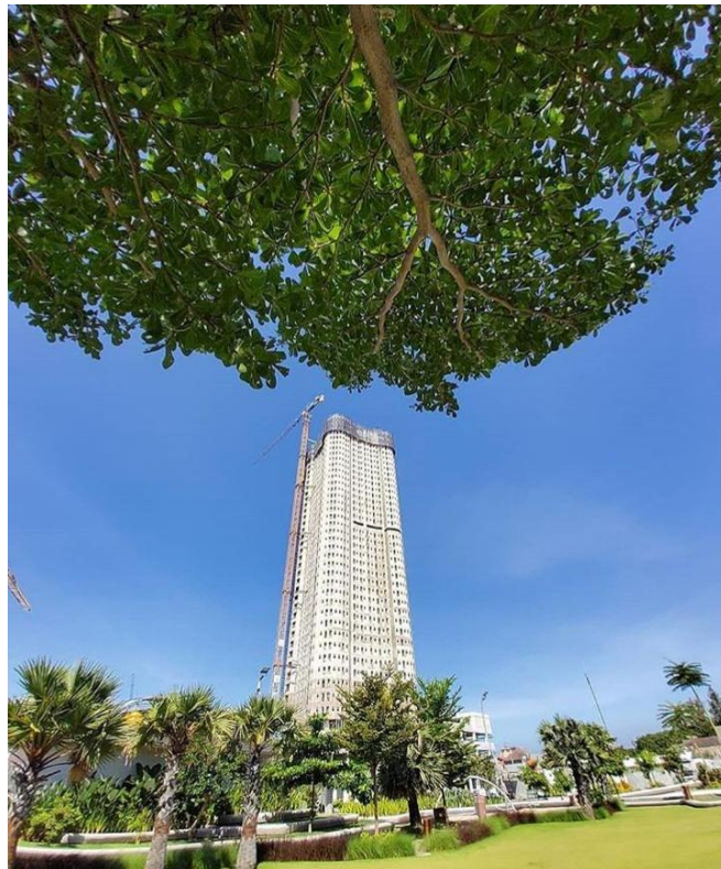
Gambar 4.16 Progres Pembangunan Olive Tower Juni 2020
