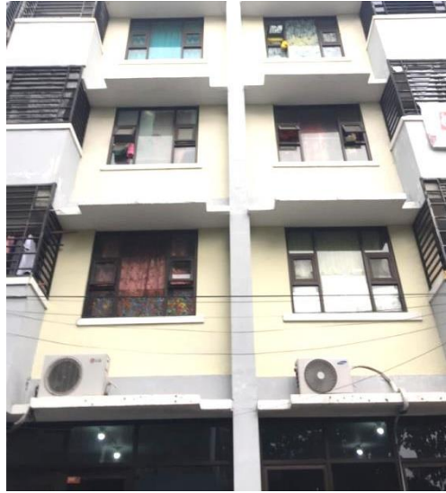
Gambar 4. 11. Elemen Fasad Jendela Rusun Grudo
