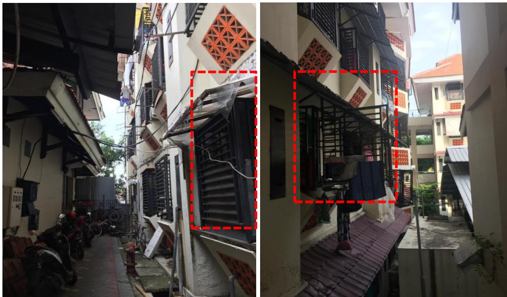
Gambar 5. 43.Ventilasi Balkon Urip Sumoharjo Lantai 1 (Kiri) dan Lantai 2-4 (Kanan)
