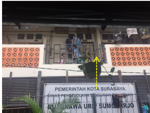
Gambar 5. 35. Pandangan dari SWK ke koridor lantai 2 Blok A Rusun Urip Sumoharjo
