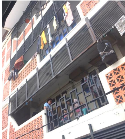
Gambar 4. 25. Fasad Jendela Rusunawa Urip Sumoharjo
