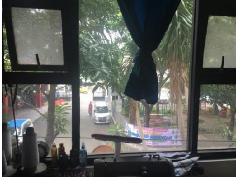
Gambar 5. 22. Kondisi jendela bagian belakang lantai 2 unit partisipan D
