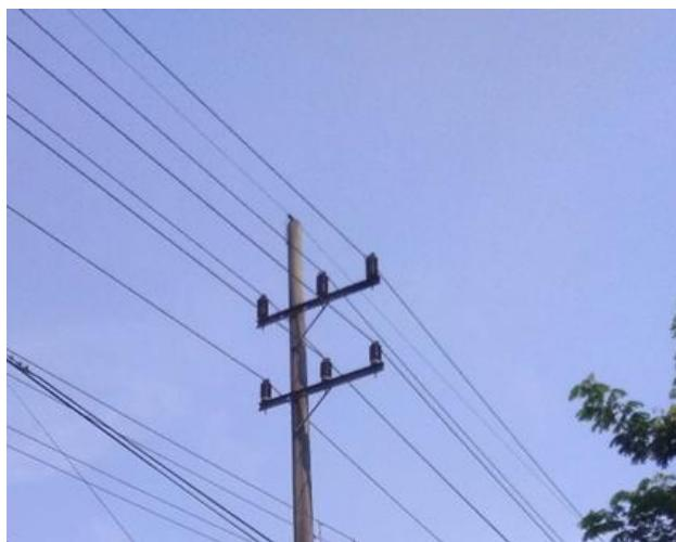
Gambar 2. 19 Saluran Udara Tegangan Menengah (SUTM)
