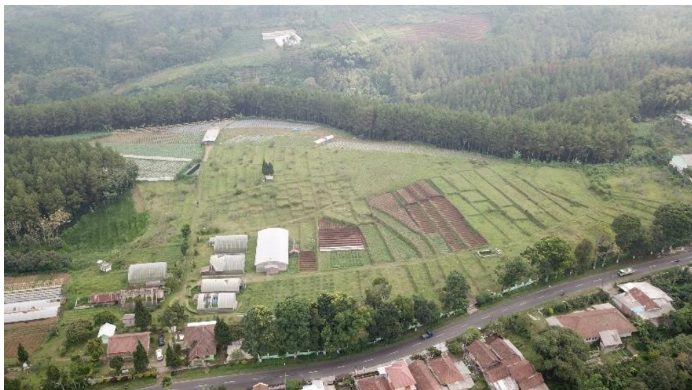
Gambar 4. 2 Lokasi Proyek via drone Sumber : dokumen usulan investasi proyek
