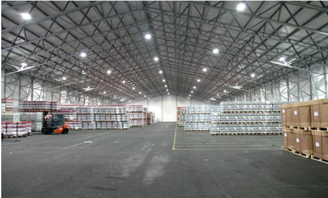
Gambar 4.2 Struktur Bentang Lebar (Sumber: http://www.solusigudang.co.id , 2020)
