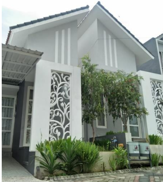
Gambar 4. 55 Taman depan unit bangunan Medina Residence 1
