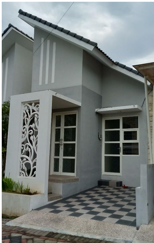
Gambar 4. 61 Secondary skin pada bagian depan unit bangunan Medina Residence 1
