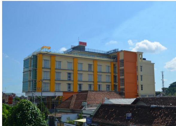
Gambar 2. 17 Gedung Edu Hostel, Yogyakarta
