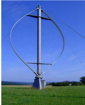
Gambar 2.2 Salah Satu Contoh Turbin Angin Sumbu Vertical Tipe Darrieus (indoenergi, 2012)
