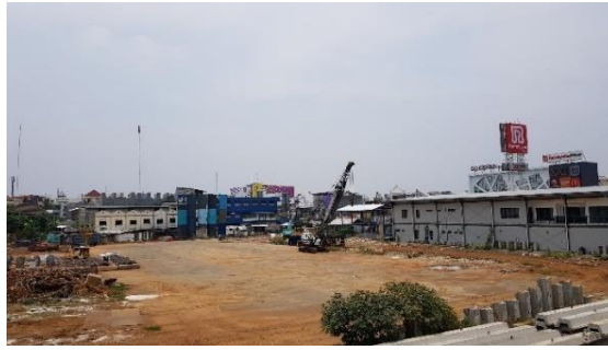
Gambar 2.11 Lahan Kosong Bekas Terminal Depok yang Diruntuhkan (Dokumentasi Pribadi, 2019)
