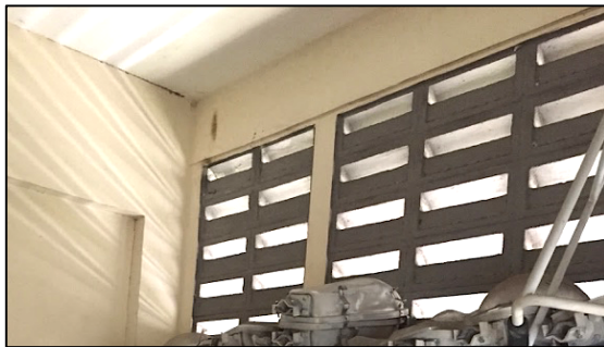
Gambar 4.7 Kondisi Ventilasi di AM ITS
