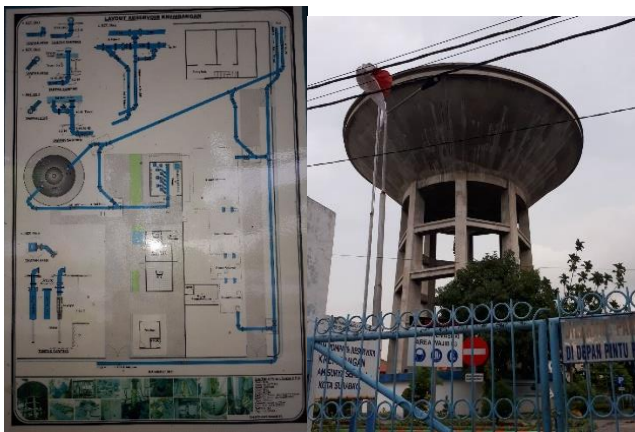
Gambar 2.5 Sistem Penyaluran dengan Tower Tank dan Bangunan Tower Tank Krembangan
