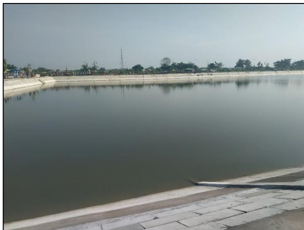
Gambar 3.5 Kolam Penampungan 1 Sumber: Dokumentasi Penulis
