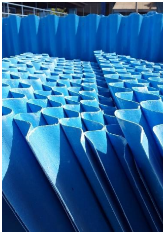
Gambar 2.13 Tube settler IPAM KP III Sumber: Paitaha dan Sholihah (2019).
