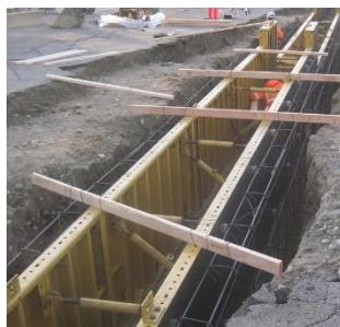
**Gambar 4. 22** Pekerjaan *Guide Wall Diaphragm Wall*
