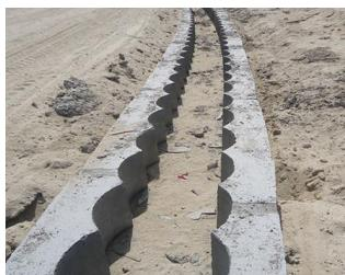
**Gambar 4. 42** Pekerjaan *Guide Wall Secant Pile*
