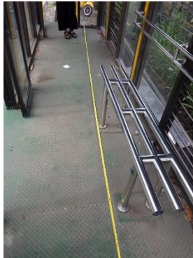
Gambar 4. 13 Kondisi halte yang tidak dijaga petugas
