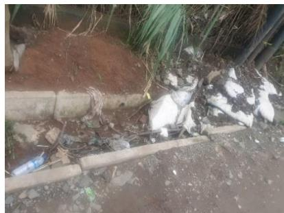
Gambar 4. 10 Saluran Tepi Drainase yang Tersumbat Sepenuhnya pada Segmen 3 Jalan Raya Legok – Karawaci
