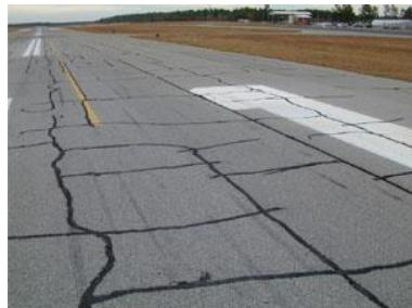
Gambar 2. 9 Contoh Kerusakan *Block Cracking*
