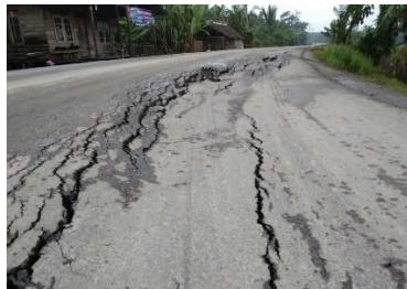
Gambar 2. 11 Contoh Kerusakan *Edge Deterioration*
