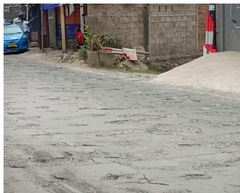
Gambar 4. 5 Kerusakan *Potholes* dengan kedalaman 2,5 – 7,5 cm pada Jalan Raya Legok - Karawaci
