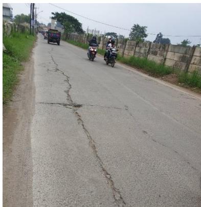
Gambar 4. 7 Kerusakan *Longitudinal Cracking* dengan Pecah >2,5 cm pada Jalan Raya Legok – Karawaci
