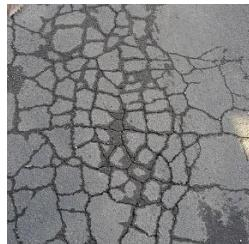
Gambar 2. 3 Contoh Kerusakan *Alligator Cracking*
