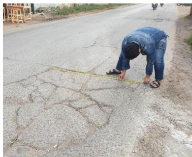
Gambar 4. 6 Kerusakan *Distortion* disertai retak pada Jalan Raya Legok – Karawaci
