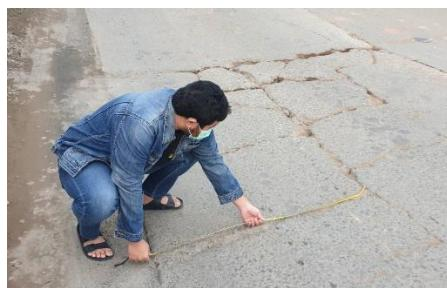
Gambar 4. 8 Kerusakan *Block Cracking* dengan retak >1 cm pada Jalan Raya Legok – Karawaci
