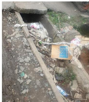
Gambar 4. 9 Terhambatnya Saluran Drainase karena Sampah dan Material pada Tepi Drainase Segmen 3 Jalan Raya Legok – Karawaci
