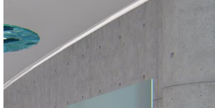
Gambar 4. 24 Pengaplikasian track light pada introduction room (Sumber : Dokumen Pribadi, 2020)
