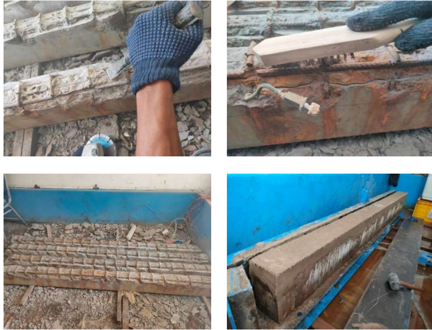
Gambar 3.9. Repair balok beton terkorosi.
