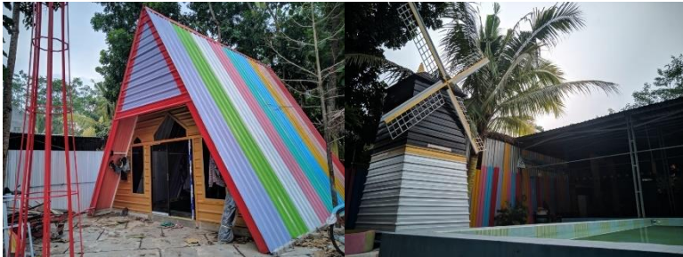
Gambar 4. 29 Bangunan Toilet dan Musholla yang Berbentuk Unik
