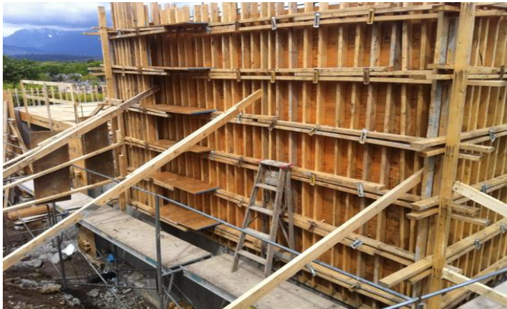
Gambar 2.1 Bekisting Konvensional (Sumber : Bekistingkonsultan.com )
