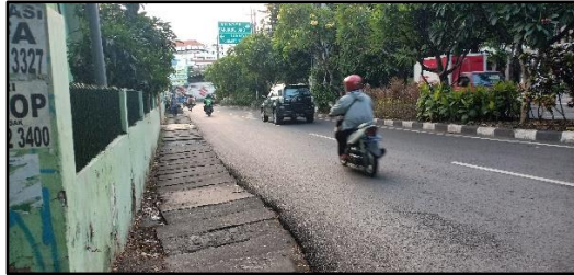
Kondisi Eksisting Jalan Kolektor Sekunder di Jl. Puskesmas Sumber: Dokumentasi Primer, 2020.
