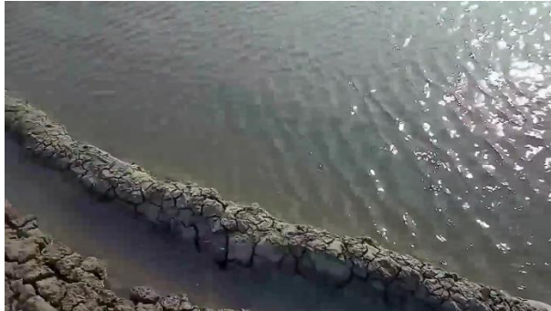
Gambar 4. 14 Saluran Tersier Sumber : Survey Primer, 2020
