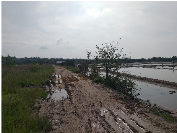
Gambar 4. 18 Kondisi Akses Menuju Zona Produksi Kawasan Pegaraman Sumber : Survey Primer, 2020
