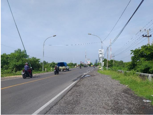
Gambar 4. 19 Kondisi Jalan Antar Kecamatan di Zona Pemasaran Kawasan Pegaraman Sumber : Survey Primer, 2020
