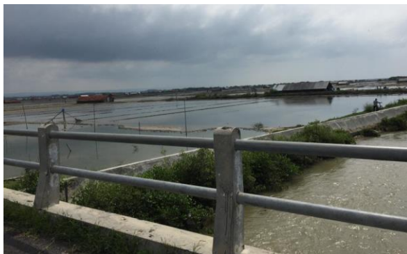
Gambar 4. 12 Saluran Primer Sumber : Survay Primer, 2020
