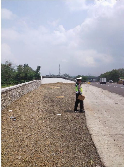
Gambar 4. 9 Gambar Kondisi Lapangan di STA 24
