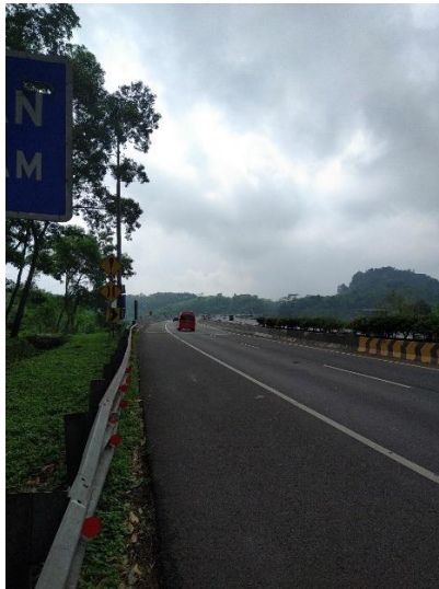
Gambar 1.4 Jembatan di STA 28
