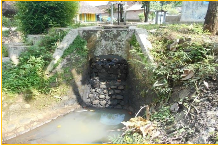
Lampiran 4. Kondisi Bangunan Sadap
