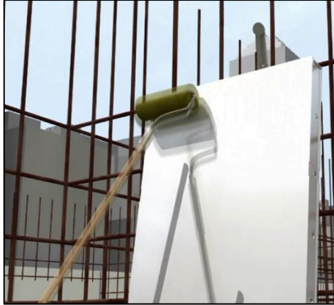
Gambar 4. 41 Pekerjaan Formwork Oil Sumber: (Dokumen Pribadi, 2020)
