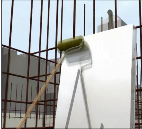
Gambar 4. 25 Pekerjaan Formwork Oil Sumber: (Dokumen Pribadi, 2020)
