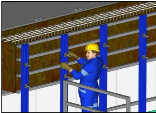
Gambar 4. 36 Pemasangan Tie Rod Sumber: (Dokumen Pribadi, 2020)
