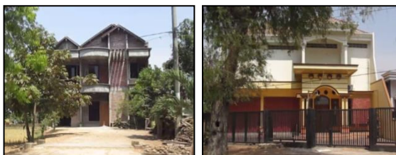
Gambar 4. 17. Kondisi Perumahan Swadaya Kecamatan Dukun
