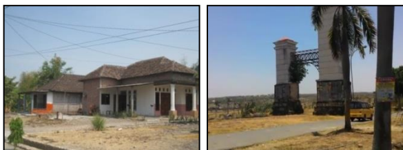
Gambar 4. 6. Kondisi Perumahan Swadaya (kiri) dan Formal (kanan) Kecamatan Kedamean
