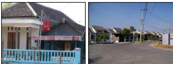
Gambar 4. 8. Kondisi Perumahan Swadaya (kiri) dan Formal (kanan) Kecamatan Cerme
