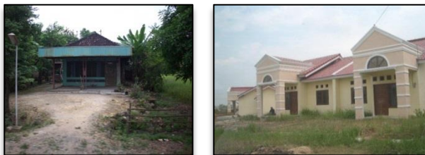
Gambar 4. 7. Kondisi Perumahan Swadaya (kiri) dan Formal (kanan) Kecamatan Menganti
