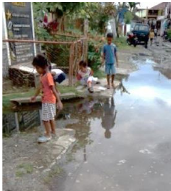
Gambar 4. 13 Kondisi Salah Satu Drainase di Kelurahan Bandungrejosari Sumber: Survey Primer, 2020
