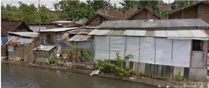
Gambar 4. 25 Kondisi Bangunan Pada Permukiman Kumuh DAS Metro
