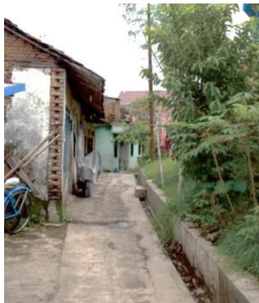
Gambar 4. 12 Kondisi Jaringan Jalan Lingkungan di Kelurahan Sukun Sumber: Survey Primer, 2020
