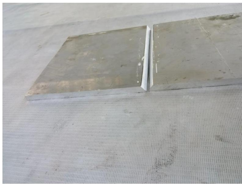
**Gambar 4.1.** Plat aluminium 5083 yang sudah dipotong dan di-bevel siap untuk dilas
