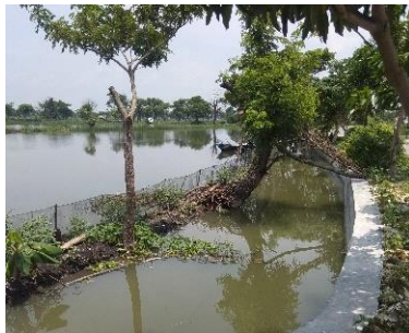
Gambar 4. 8 Saluran irigasi sawah tambak sebagai pembawa air masuk dan keluar sumber air tambak
