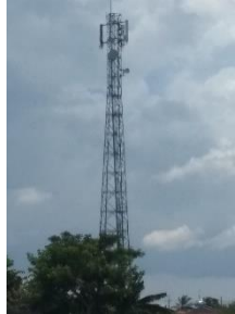
Gambar 4. 9 Tower BTS di wilayah studi
