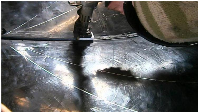
Gambar 2.10 Proses pengelasan HDPE
