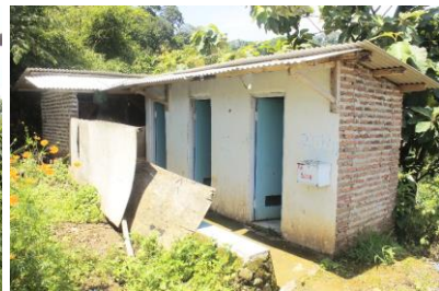
(Toilet di Kolam Renang)
