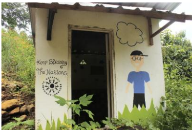
(Toilet di Bukit Pelangi)
