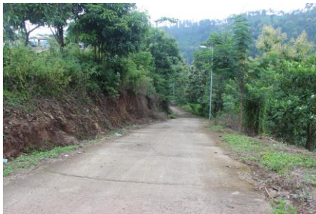
Gambar 4.72 Jalan Beton Menanjak Menuju Tempat Parkir
