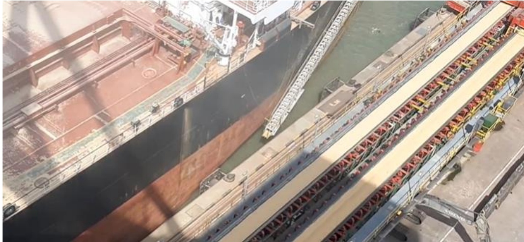
Gambar 2.5 Konveyor Penghubung Dermaga dan Silo (Sumber: PT Terminal Teluk Lamong)
