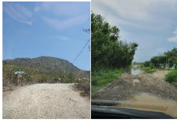
Gambar 4. 21 Kondisi Jalan menuju Pantai Pancer
