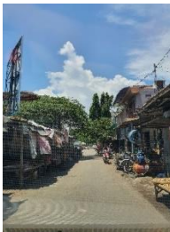
Gambar 4. 22 Kondisi Jalan menuju TPI Puger Sumber : Survey Primer, 2020
