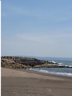
Gambar 4. 6 Bangunan Break Water
