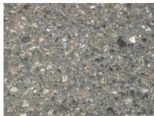
Gambar 2.4: Contoh pengausan pada jalan [1]
