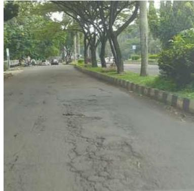
Gambar 2.1: Contoh retak pada jalan
