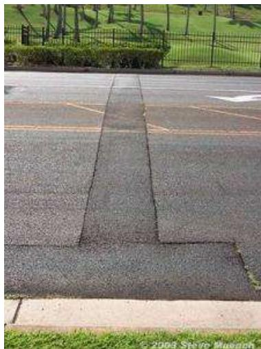
Gambar 2.6: Contoh penurunan pada bekas penanaman utilitas pada jalan [1]
