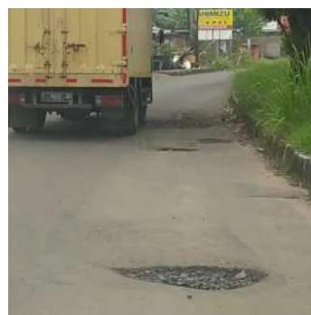
Gambar 2.3: Contoh cacat permukaan pada jalan
