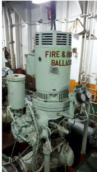
Gambar 2. 3 Pompa Fire, Bilge, dan Ballast
