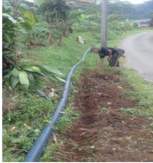
**Gambar 4.6 Proses Pemasangan Pipa Transmisi**
