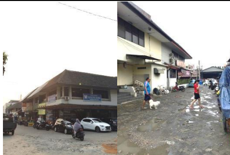
Gambar Jalan Lingkungan yang Rusak Pada Segmen 3.
