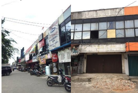
Gambar Perdagangan dan Jasa Berupa Bangunan Ruko pada Segmen 2.
