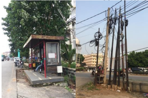
Gambar Feeder Bus yang Jarang Beroperasi dan Kelistrikan Pada Segmen 4.
